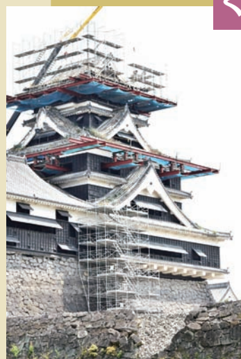
修復工事中の熊本城。400年以上の歴史を誇るこの城も、2016年の地震で被害を受けました。
