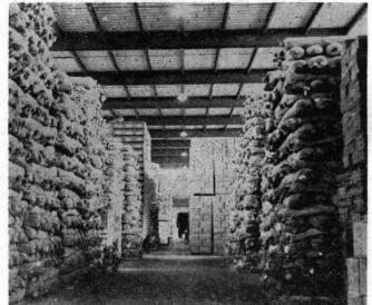
焼ける前の不燃性建物の中の重い"火災荷重"。ボール箱に入つ たゴムホースと麻袋に入つた真空掃除機の部分品が燃えて建物 が崩壊した (第4図の通り)。屋根は露出した鉄骨の梁の上に石 膏板を張つてあつた。三棟の建物が一火災区域を構成していた。
