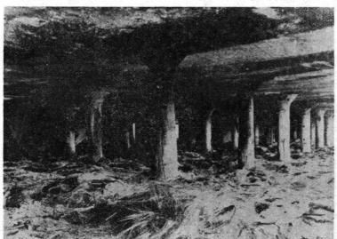
第2図 タイヤが14時間燃えたが、柱は尚、 荷重を支え ヤのビード線の焼残りに注意。
