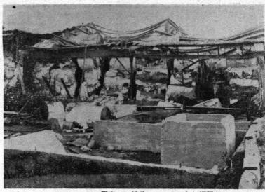
露出した鉄骨にアルミニウム板張り。
