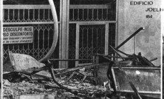
写真-3 一階正面入口と 落下したルームクーラーの残骸。
