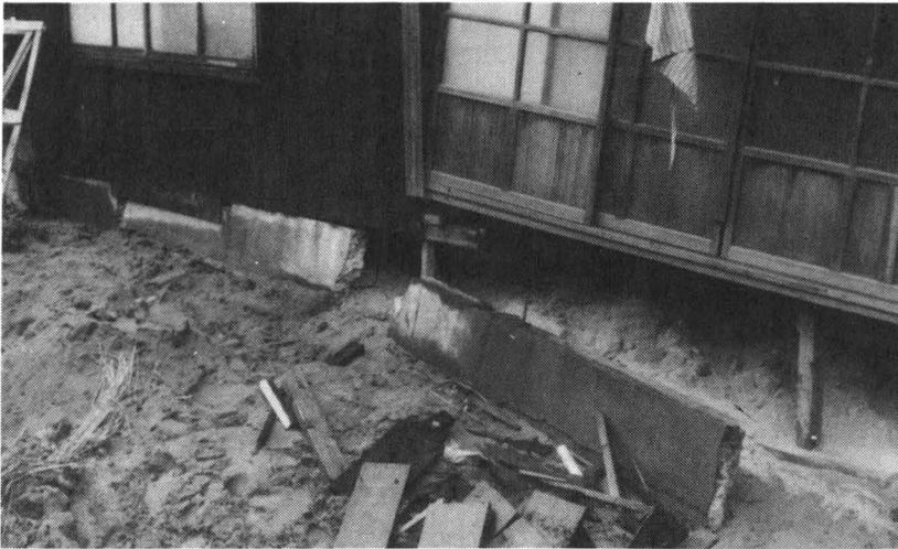
写真6 地盤が壊れ不同沈下したとき、布基礎に鉄筋が入っていなければ役に立たない例(新潟地震)
