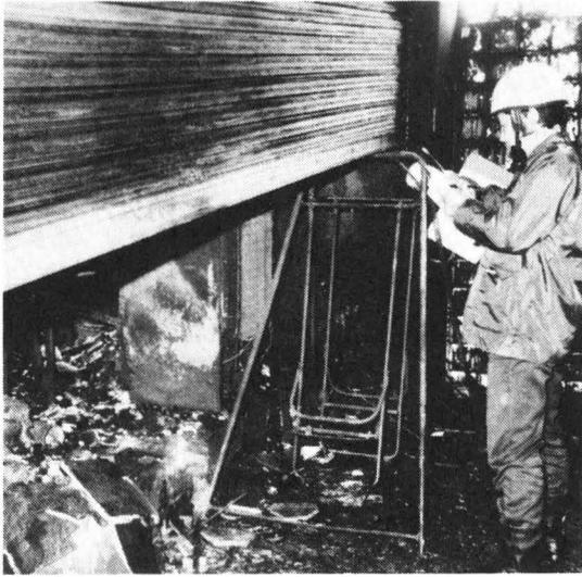
火災・特異火災837件のなかには、防火戸の管理や設置の不備が大きくなった火災が23件あり、このうちの約半数が防火戸が開いたままになっていたことに原因しているとされている。このなかには、防火戸の開放を維持するためにくさびをかませたもの（あなたのビルの防火戸をよく観察してみるといい）や、窓や開口部の防護が不完全であったり、火災時にヒューズや火災感知器と連動している自動閉鎖式の防火戸が、その周辺に物品が置かれていたために完全に閉鎖できなかつたりして延焼したケースなどが多く含まれている。これらは「しり抜け防火戸」や「閉まらない防火戸」の典型例というべきもので、このように、火災の防護装置の設置や操作に致命的な欠陥や不全があれば拡大するのは当たり前で、この当然の原理が火災を生じて初めて露呈されるのである。
