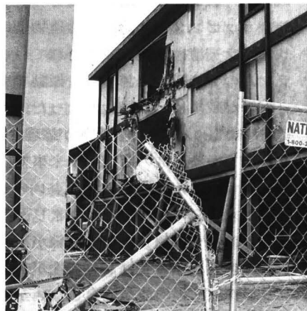
写真2 危険区域を囲うフェンス
