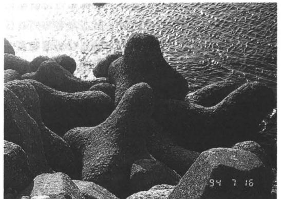
写真2 富山県吉原海岸のブロックの摩耗状態
