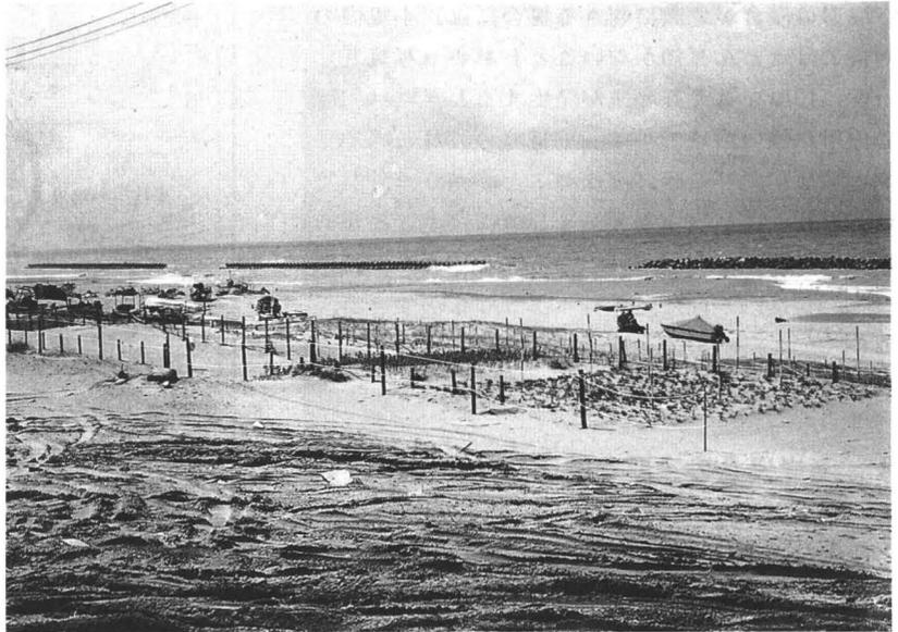
写真9 離岸堤が設置され、砂浜が付き始めている状況
