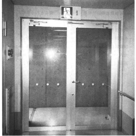
写真3 自動及び遠隔操作により解錠できる出入口
