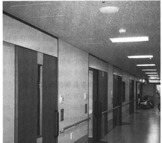
写真4 煙感知器と連動で閉鎖する入居室の扉と、廊下の天井に設置してある煙感知器とスプリンクラー
