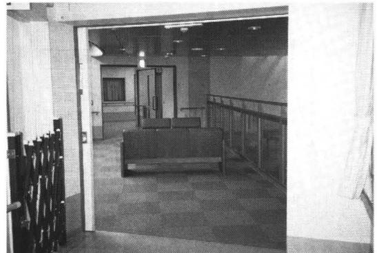
写真5 煙感知器と連動で閉鎖するゾーン区画の防火戸
