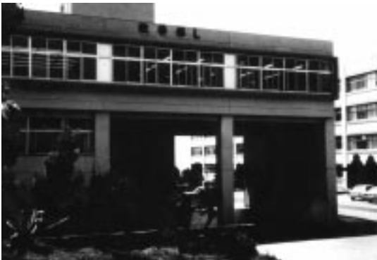
a) RC造壁の増設（上：補強前 下：補強後）
