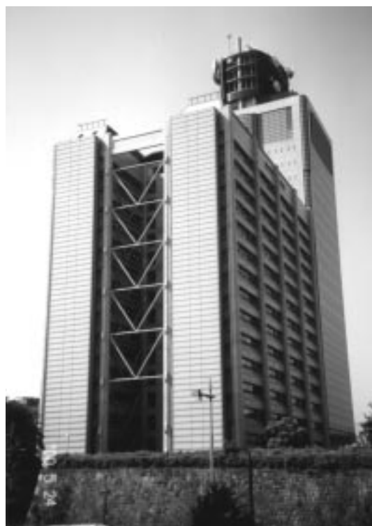
写真5 制震ブレースによる補強事例 (中央の X型ブレースが補強用制震ブレース)
