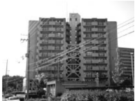
写真4 住棟間への補強ブレースの設置事例
