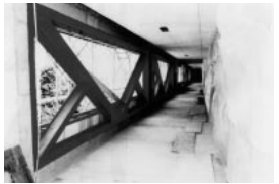
(b) 枠付き鉄骨ブレースの増設
