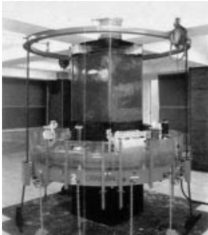
写真3 炭素繊維による柱の補強事例 （黒色部分、円形装置は繊維巻き付け装置）
