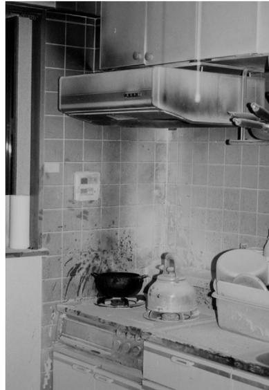
写真1 事例2の天ぷら油火災の焼損状況
