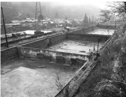
写真3 沈殿池（公害防止工事で建設された沈殿池（2009年））
