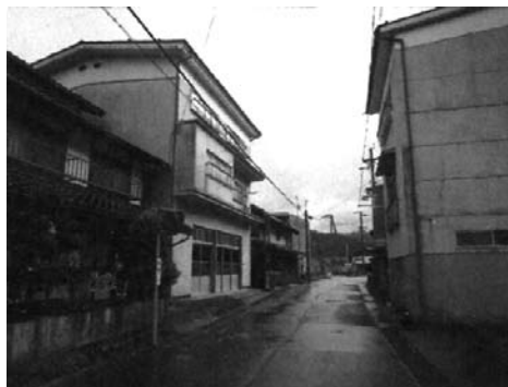
写真 2004年の水害後に造られた水屋 （三階建ての街並み）
