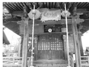
写真3 仙台市太白区长町の蛸薬師 ※37ページにカラーの大きな写真があります。
