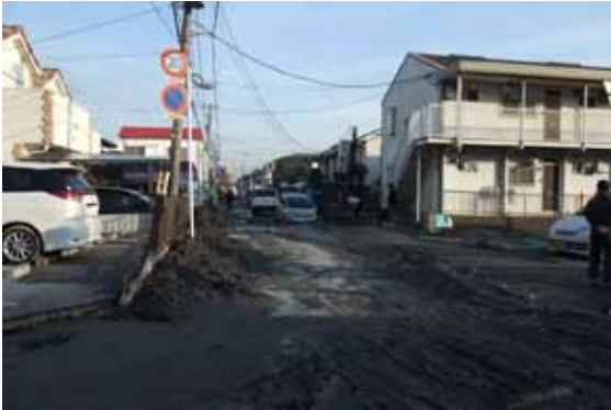
写真1 地震翌日の浦安市の状況 (発生した噴砂を取り除いているところ。背後の家々が沈下・傾斜している。)
