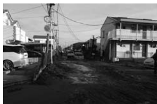
写真1 地震翌日の浦安市の状況
