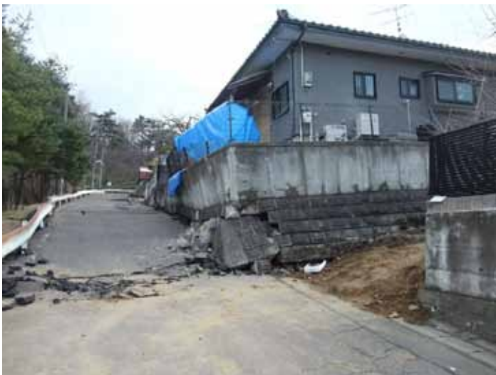
写真2 仙台市青葉区折立における造成宅地盛土の被害 (盛土の変状原因は地震力によるすべり破壊が多いと思われるが、中には噴水・噴砂も発生し、明らかに盛土材の液状化による被害も発生している。)
