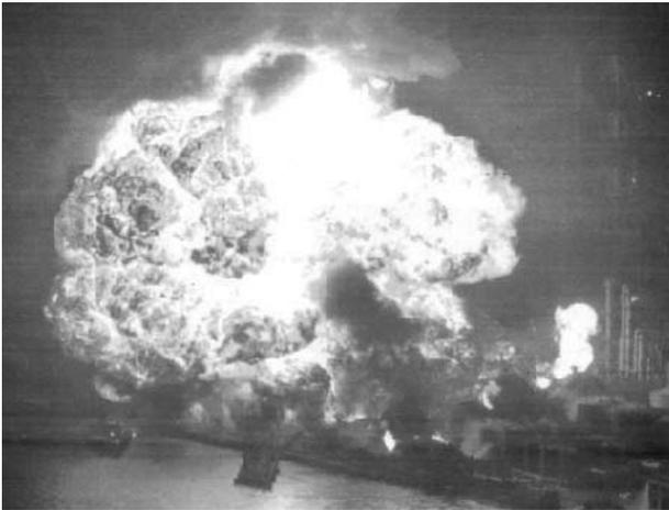
写真12 ガスタンクの爆発に伴い発生したファイヤーボール (推定直径は600~750m)
