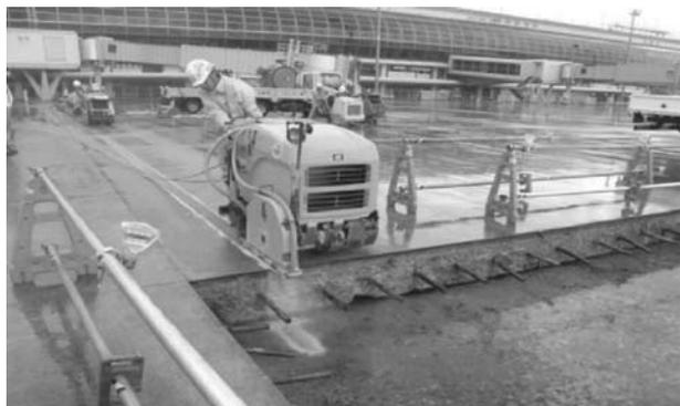
写真12 既設コンクリート舗装版切断状況
