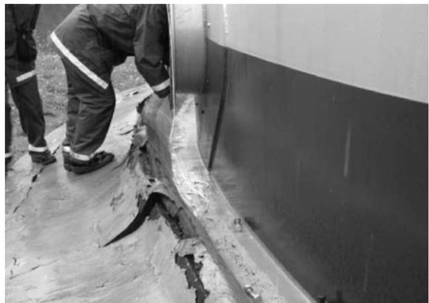
写真16 タンク沈下、基礎の変形
