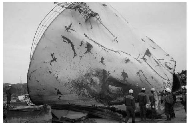
写真5 津波により移動、倒壊したタンク
