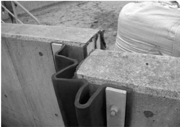
写真18 防油堤の破断状況 (ゴムシートは破断していない)
