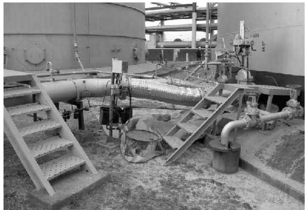
写真15 タンク付近が液状化、タンクが沈下
