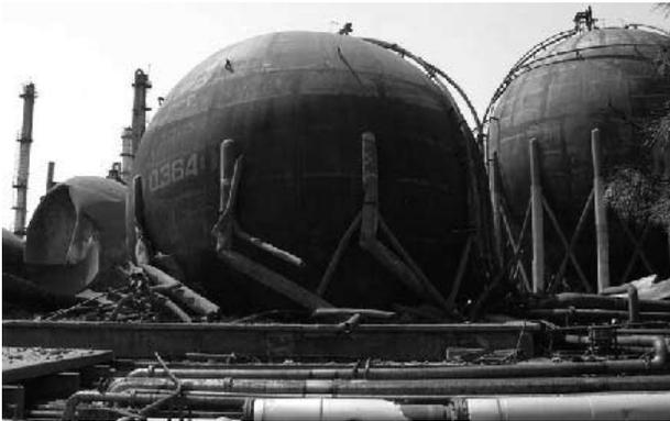
写真11 ガスタンクの支柱が座屈し配管が損傷
