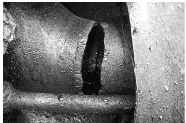
写真4 破断した重油タンクの配管
