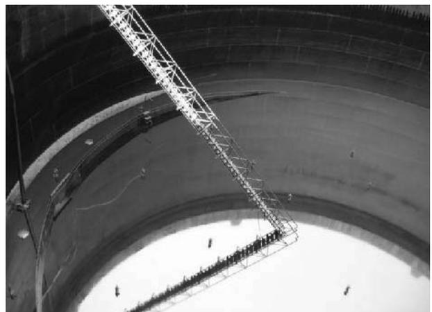
写真21 浮き屋根の沈没
