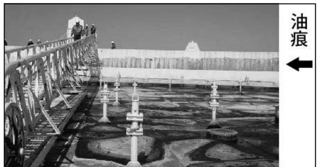
写真19 スロッシングによるデッキへの溢流
