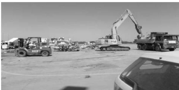
写真11 瓦礫積込状況(バックホウ ハサミ)
