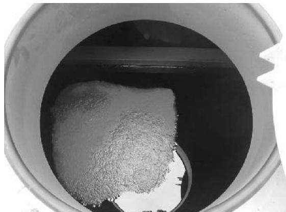
写真20 ポンツーン内への原油の滞油
