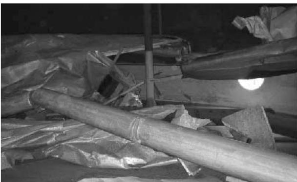
写真22 大破したアルミ製の内部浮き蓋
