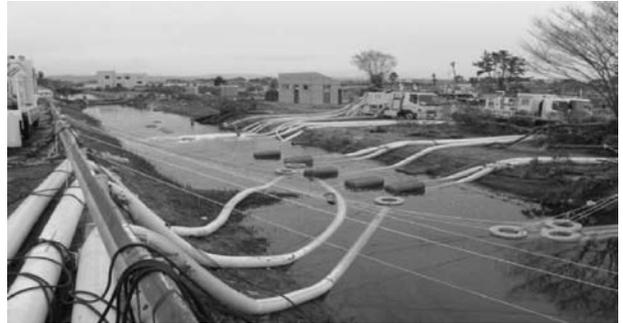
写真8 排水ポンプ車による鈴木堀排水作業状況
