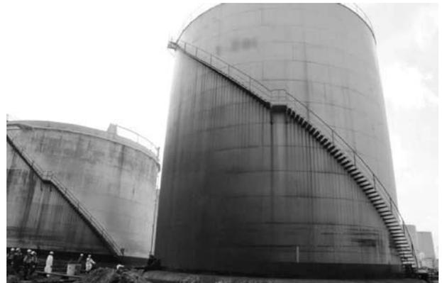
写真3 重油が漏洩したタンク（側板には漏洩した際に飛散した油が付着している）
