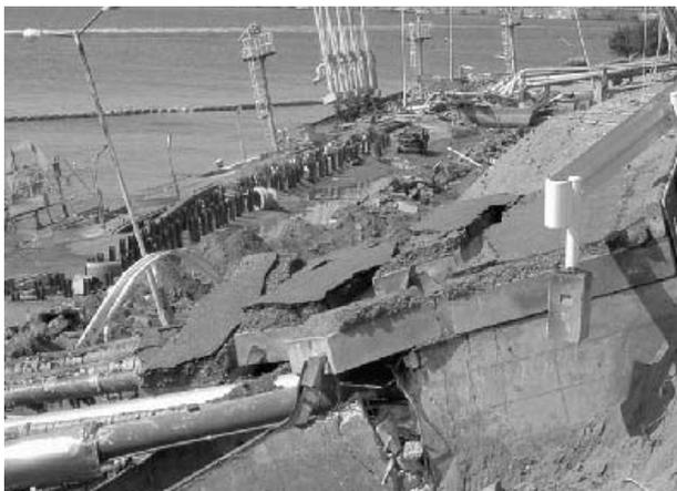
写真7 護岸の被害
