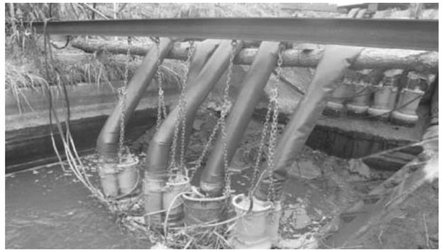
写真9 仮設ポンプ設置状況
