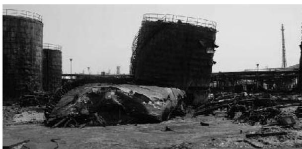
写真10 倒壊したアスファルトタンク
