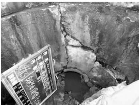
写真2 接続部のひび割れ
