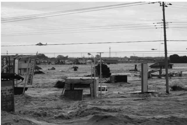
写真 破堤して 4 時間後の様子 (9 月 10 日)
