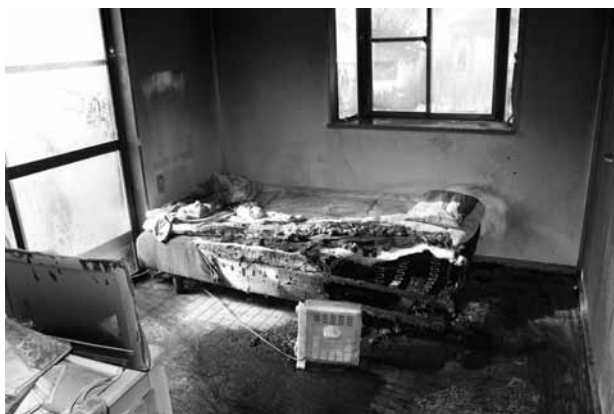
写真2 住宅用火災警報器の奏功事例
