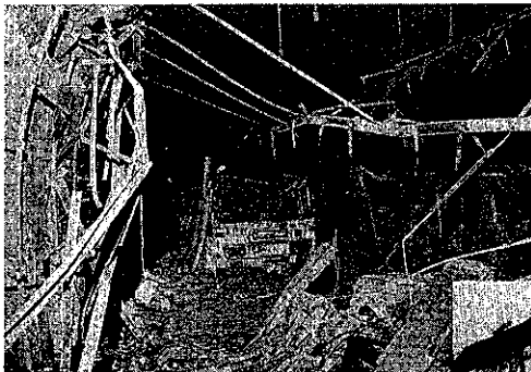
東名高速日本坂トンネルの火災事故
